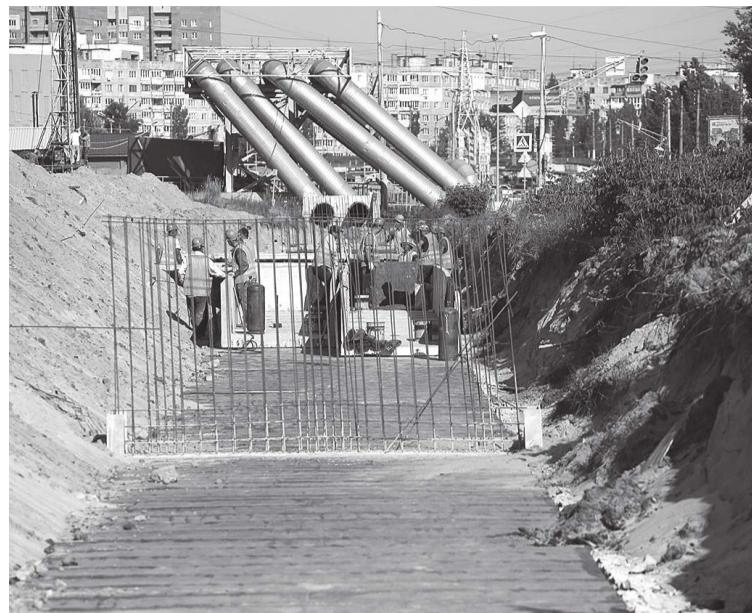
щее время АО «Теплоэнерго» проводит второй этап реконструкции сети – замену 1,8 км труб диаметром 800 мм на трубы диаметром 1000 мм. В рамках первого этапа – летом 2020 года – подрядчик построил теплосеть протяженностью два километра в однотрубном исполнении. Магистральная теплотрасса обеспечивает теплоснабже-
