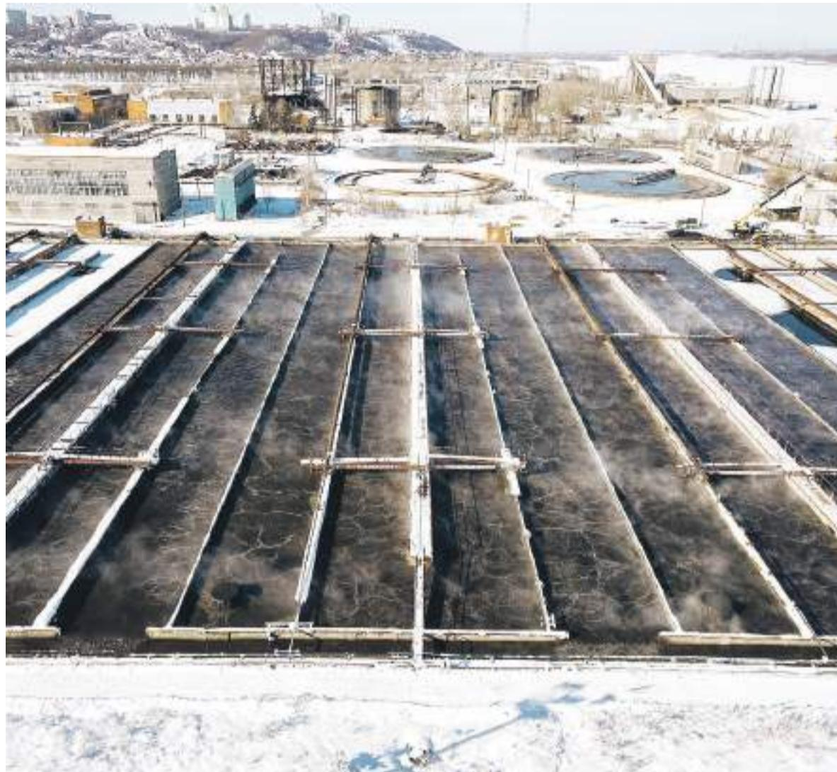
Очистка сточных вод на Нижегородском водоканале вышла на новый уровень. Компания завершила вторую очередь модернизации аэротенков (это система активного биологического очищения сточных вод) на Нижегородской станции аэрации. В новых конструкциях установлено оборудование нитрификации и денитрификации, которого раньше на станции не было. Соответственно улучшается качество питьевой воды.
