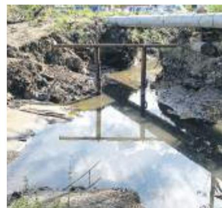
В речку Кову выходят сразу три ливневых коллектора: с Ковалихинской улицы диаметром 1300 мм, улицы Белинского диаметром 1000 мм и Сенной площади диаметром 800 мм. Из-за того, что в русло реки кто-то сбрасывал строительный мусор, во время дождей и паводка он блокировал выход из ливневки, и случались подтопления. По данным Нижегородского водоканала, в прошлом году отсюда вывезли 30 грузовых машин мусора, в этом году — 10.
